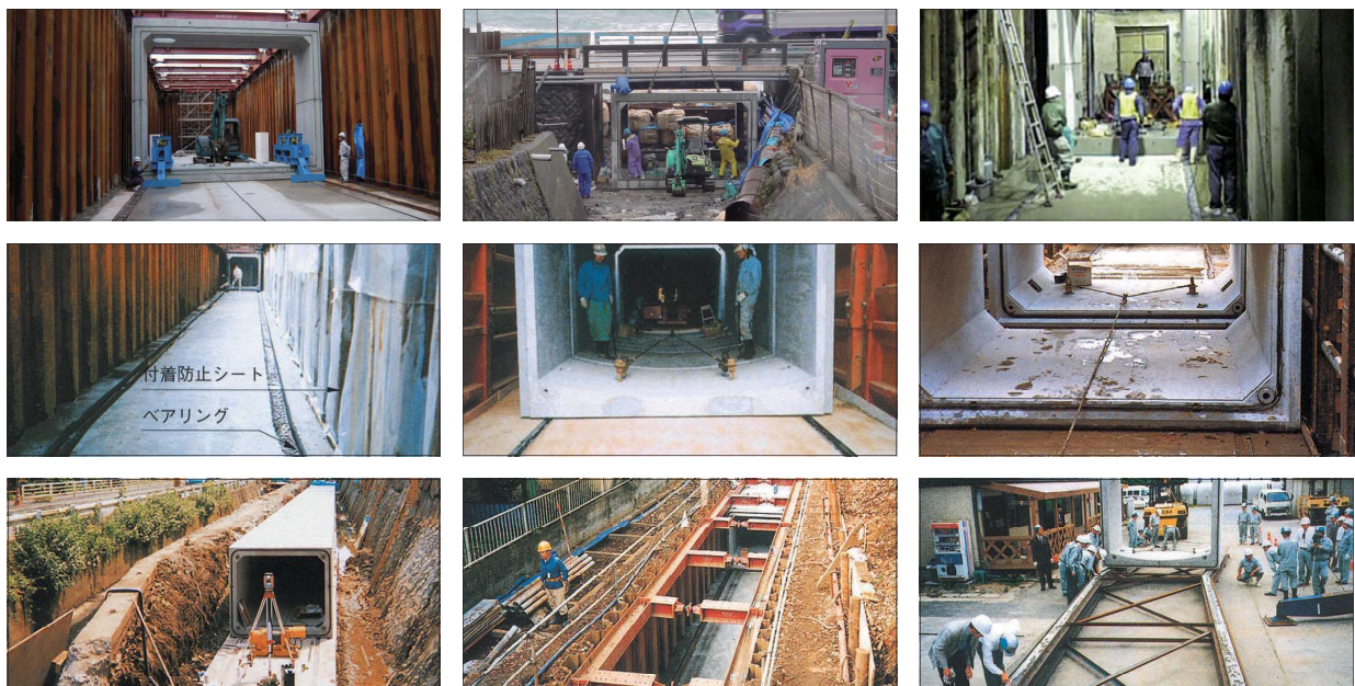
■カーブ施工実験風景
