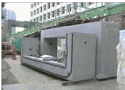
■R&C工法用ボックスカルバートの一例
