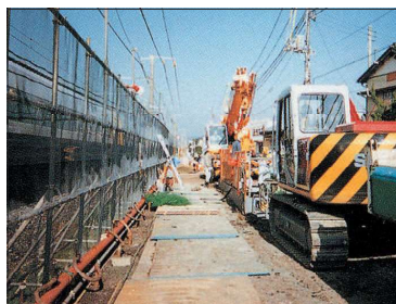
■鉄道近接施工
