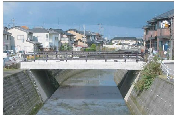
■石川県金沢市／太郎田橋上部工架替工事
