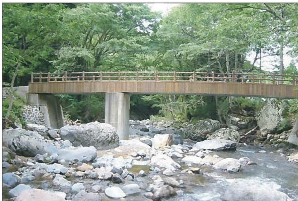
■石川県小松市／久保橋上部工架替工事
