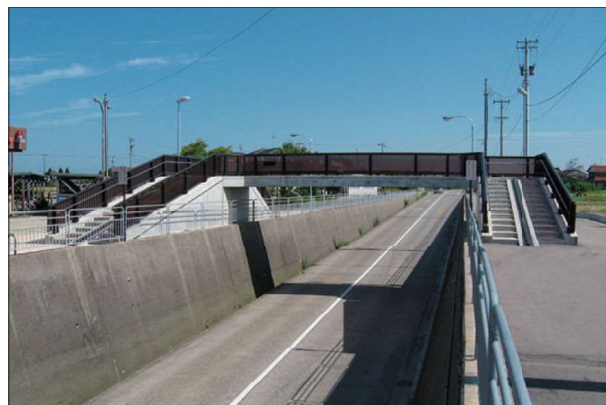
■石川県小松市／明峰熊野横断歩道橋
