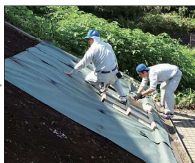
■雑草シート敷設
