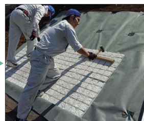
■製品敷設(目地を割り不陸に追従させる)
