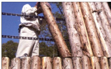
間伐材を建て込む 間伐材の形状を確認しながら出来るだけ隙間なく垂直になるように建て込みます。
