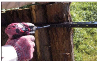
間伐材固定 カチオンフレームに4cm間隔で空いている穴から専用の六角ボルトビスで間伐材を固定します。
