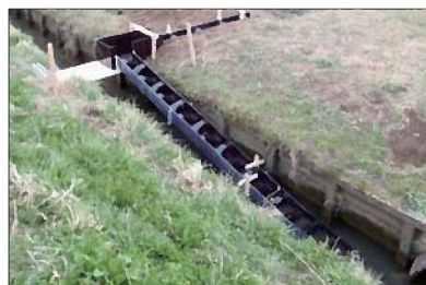
■ 水田と排水路の段差
