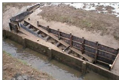
■ 低勾配(1:7)での施工事例
