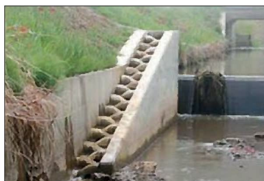
■ 高勾配(1:5)での施工事例
