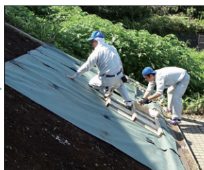
■雑草シート敷設
