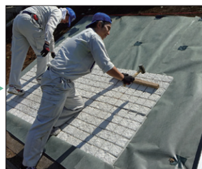
■製品敷設(目地を割り不陸に追従させる)
