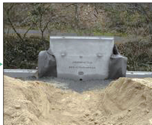
■背面の掘削状況
