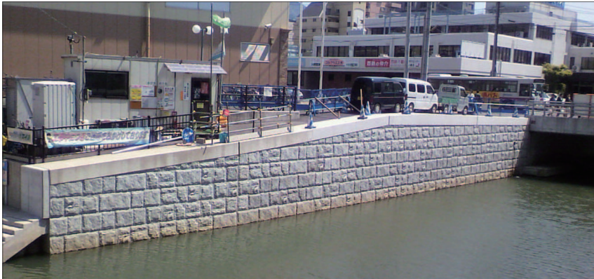
■「福岡県」福岡県北九州市役所 砂津川護岸工事
