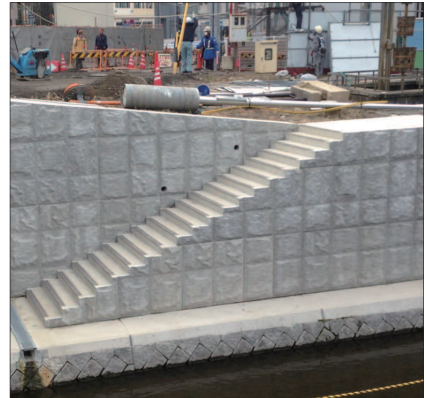
■「愛知県」名古屋市役所 都計上飯田線夫婦橋改築工事
