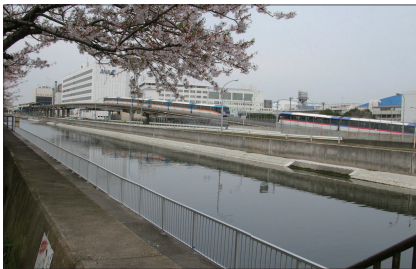
■「東京都」東京都第二建設事務所 海老取川護岸防災工事
