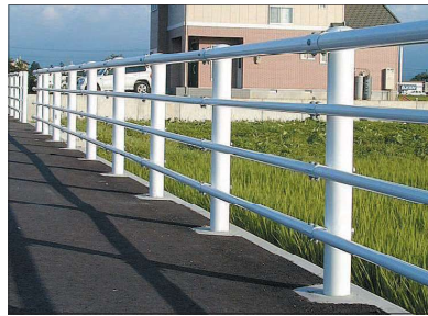
■無駄のないスッキリした歩道
