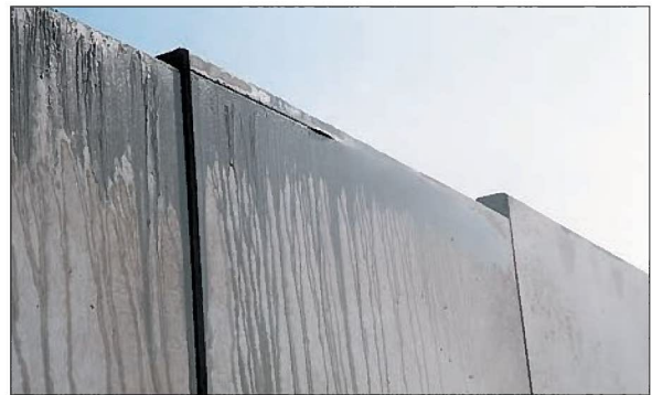
■施工中／擁壁外面
