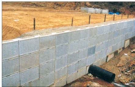
■重力式擁壁タイプ施工例
