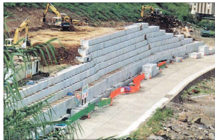
■緑化擁壁タイプ施工例
