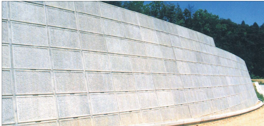
■もたれ式擁壁タイプ施工例
