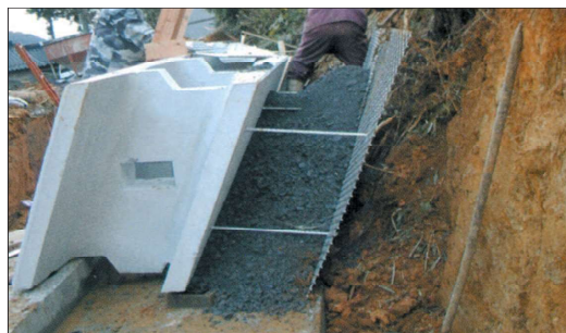
■一段目の裏込碎石充填状況
