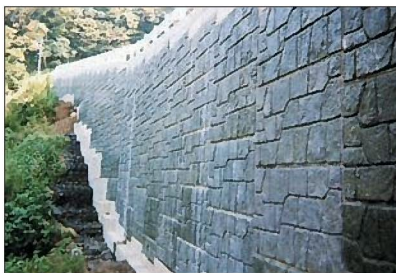
■急傾斜地の盛土
