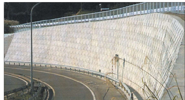
■壁面勾配をつけた施工例
