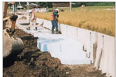
■L型擁壁の背面盛土
