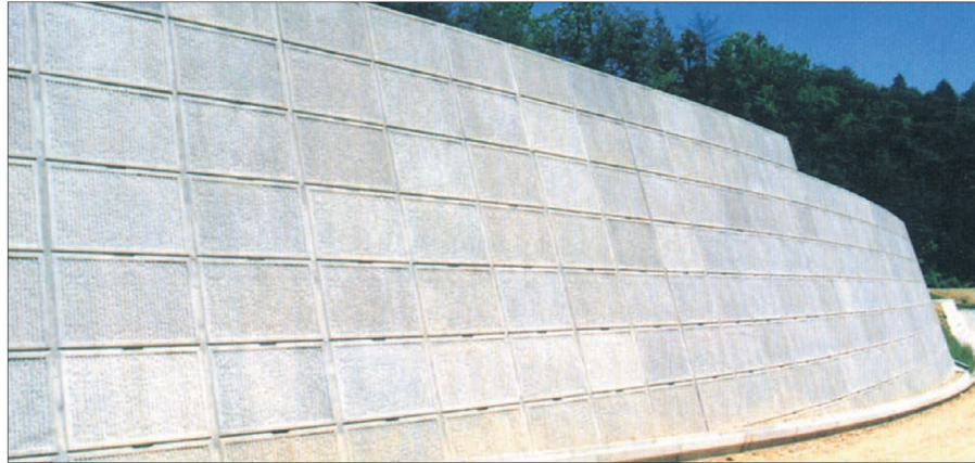
■もたれ式擁壁タイプ施工例
