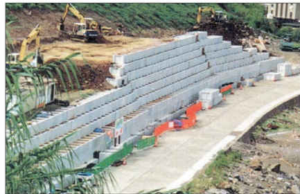
■緑化擁壁タイプ施工例
