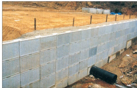
■重力式擁壁タイプ施工例
