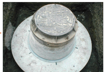
■ブロック設置完了
