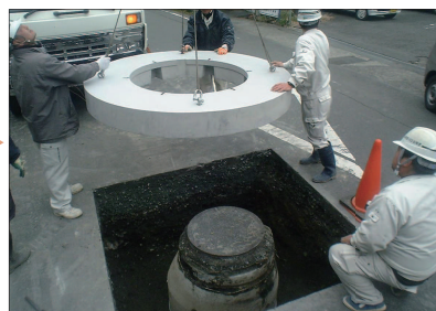
■ブロック設置
