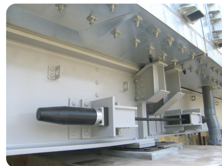
落橋防止構造
