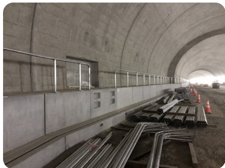
監視員通路ハンドレール
