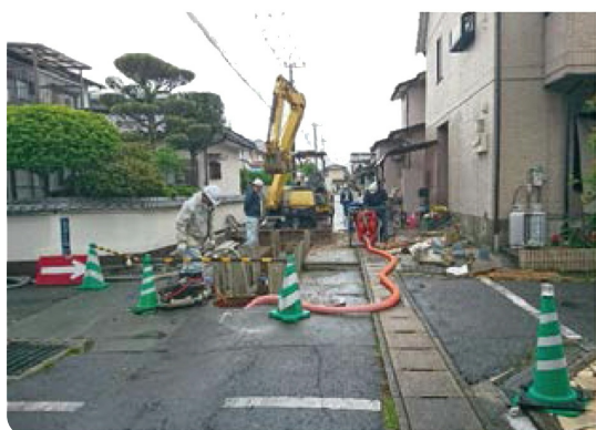
震災復旧 (熊本県熊本市)
