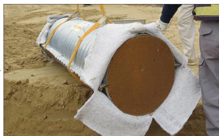
■吸出防止材を土柱ブロックに固定する。
