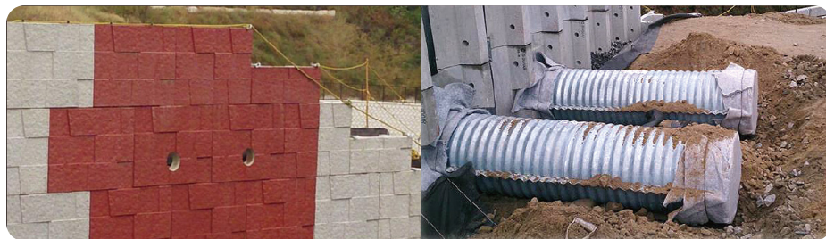
補強土壁使用例／新東名高速道路【NEXCO 中日本】愛知県
