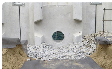
■土柱ブロックを施工するブロックに穴を開ける。
