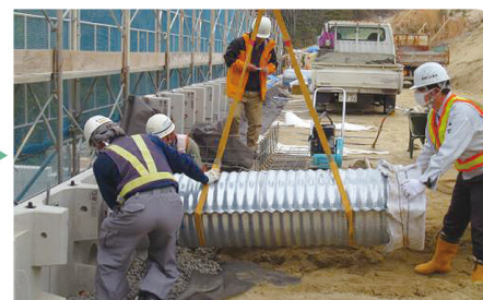
■設置位置まで移動、ブロック背面と密着させる。
