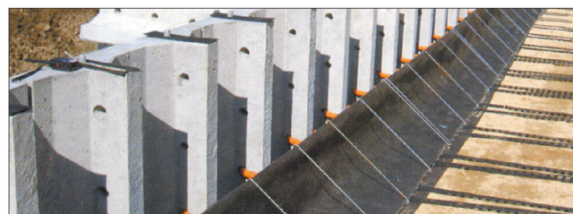
■ 締固め前の背面施工状況
