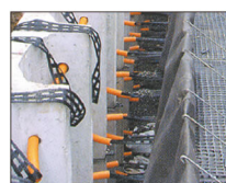
■ 砕石型枠変形前
