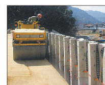
■ 壁面近傍転圧状況
