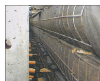
■ 砕石型枠変形後
