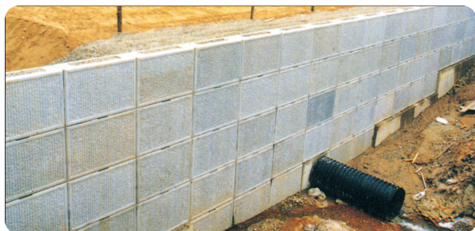
重力式擁壁タイプ施工例
