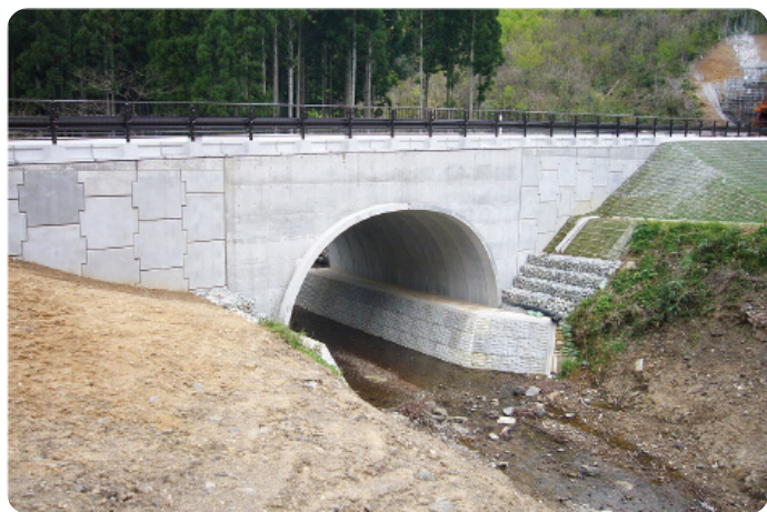
■石川県一般県道荒木原町線 施工延長14m (11,000 x 4,800)
