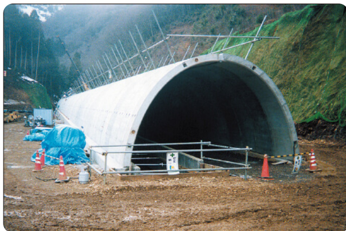
■近畿自動車道敦賀線 高浜トンネル東工事 施工延長138m (6200 X 3700)
