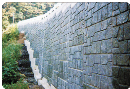
急傾斜地の盛土
