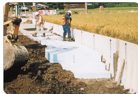
L型擁壁の背面盛土
